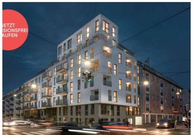
Arndtstraße 50 | Fassade Nacht
