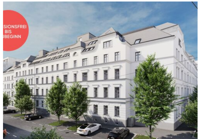
Rosegggasse | Fassade Tag
