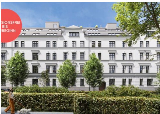
Rosegggasse | Fassade Frontal
