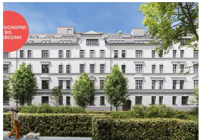
Rosegggasse | Fassade Frontal
