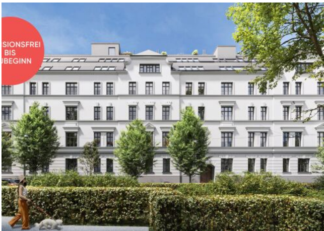
Rosegggasse | Fassade Frontal
