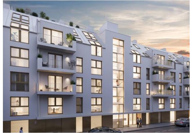
Schumannngasse | Fassade Straße
