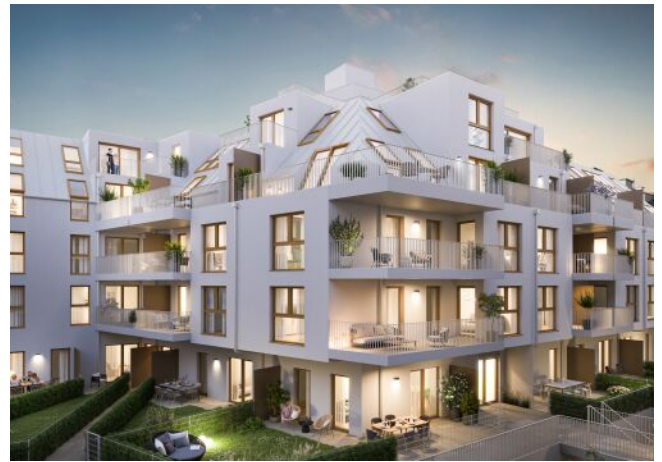
Schumannngasse | Fassade Nord Abend
