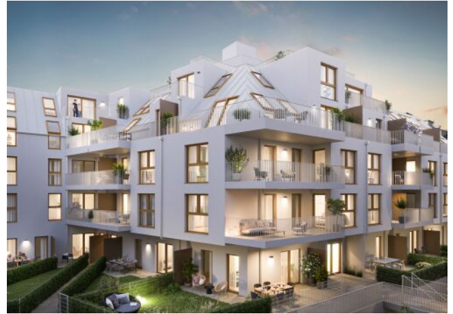
Schumanngasse | Fassade Nord Abend
