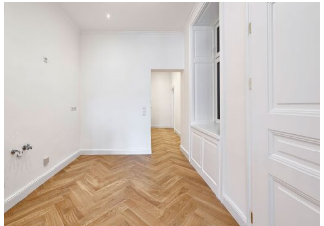
Küche | Beispiel Sanierung
