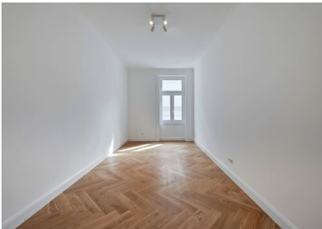
Zimmer | Beispiel Sanierung
