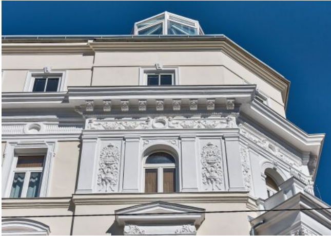
Leibenfrostgasse 8 | Fassade Detail
