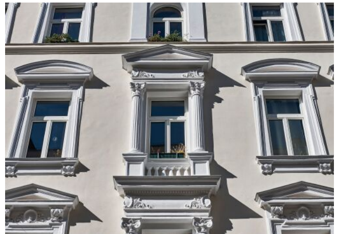
Leibenfrostgasse 8 | Fassade Detail
