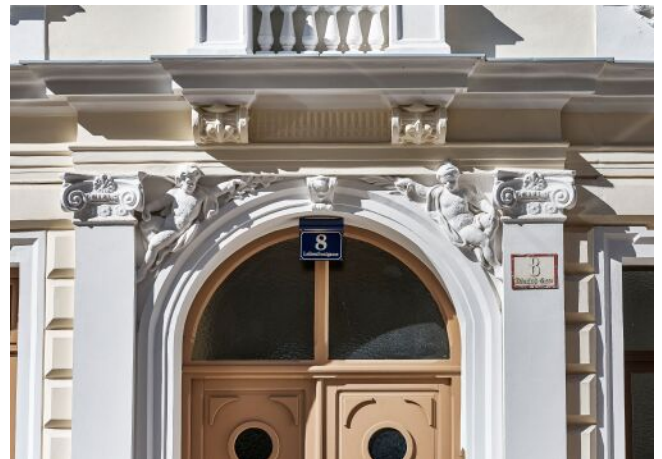
Leibnizgasse 8 | Fassade Detail
