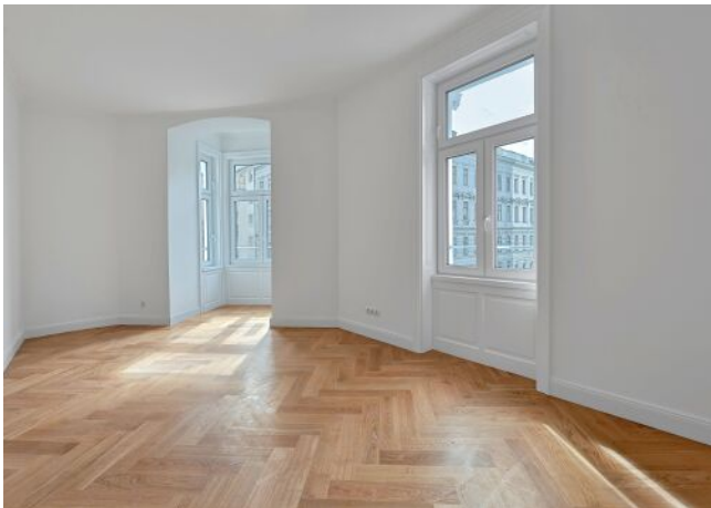
Wohnraum | Beispiel Sanierung
