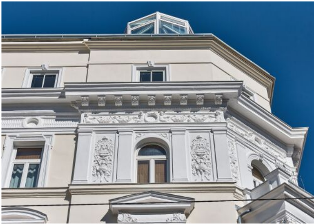
Leibenfrostgasse 8 | Fassade Detail
