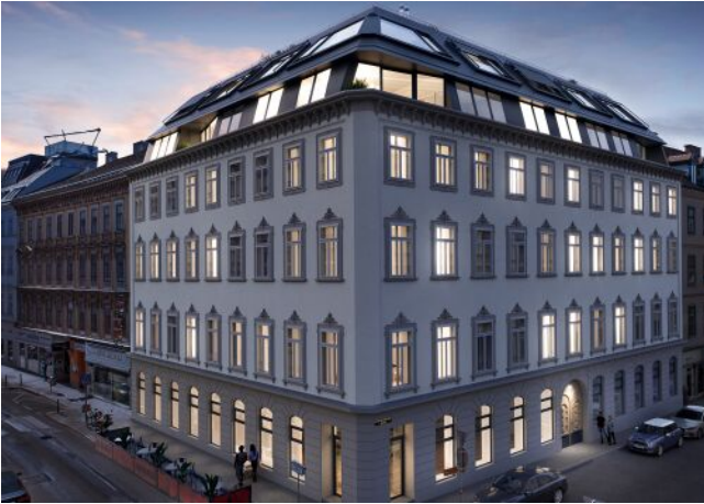
Essenz No. 1 | Fassade Abend
