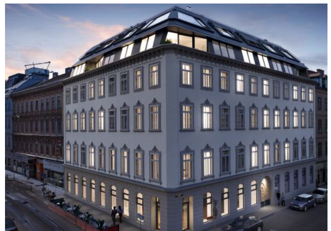
Essenz No. 1 | Fassade Abend
