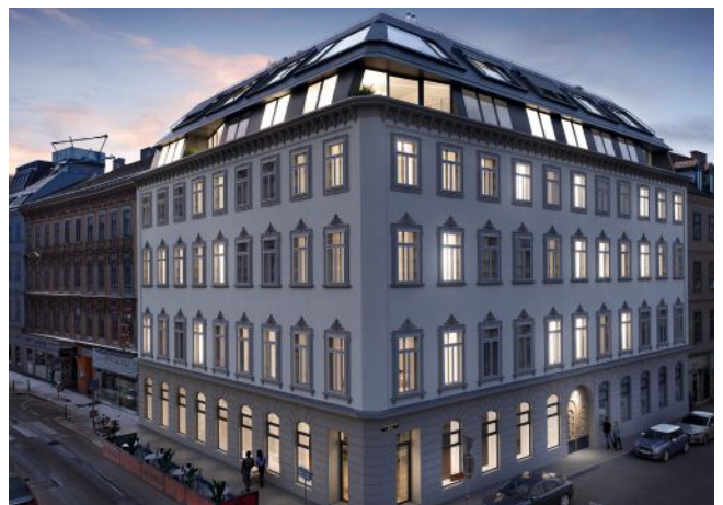
Essenz No. 1 | Fassade Abend
