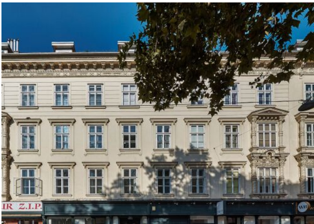
Schönbrunner Straße 20-24 | Fassade
