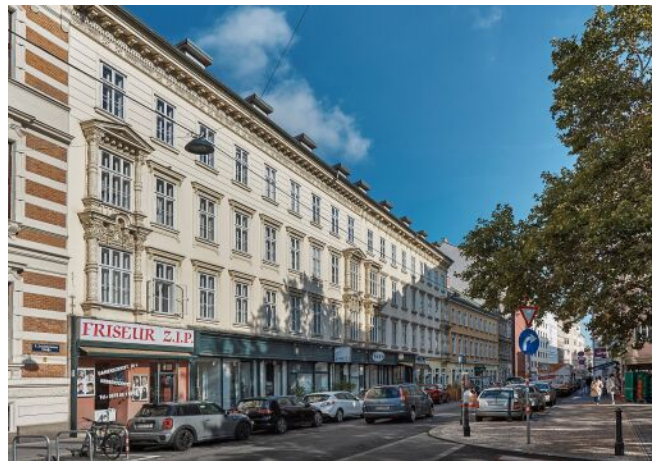
Schönbrunner Straße 20-24 | Fassade
