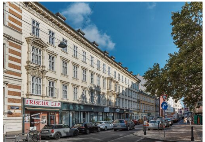
Schönbrunner Straße 20-24 | Fassade
