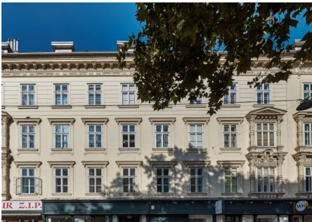
Schönbrunner Straße 20-24 | Fassade
