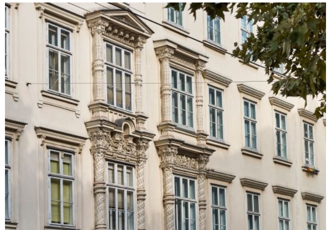
Schönbrunner Straße 20-24 | Fassade
