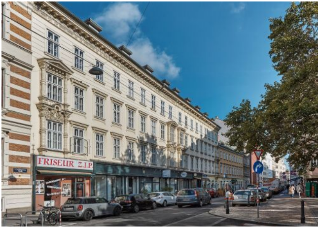
Schönbrunner Straße 20-24 | Fassade
