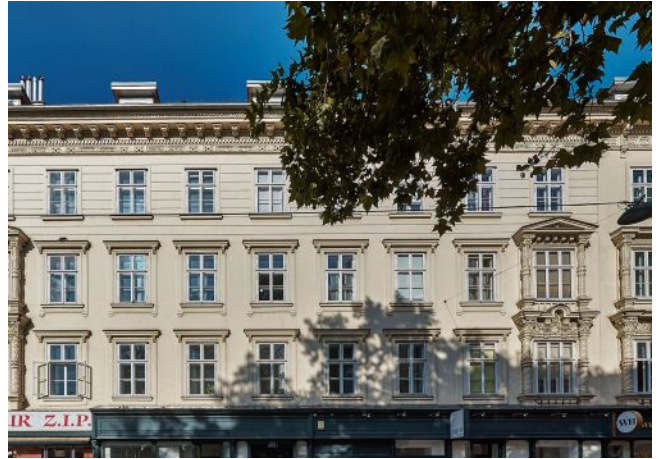
Schönbrunner Straße 20-24 | Fassade
