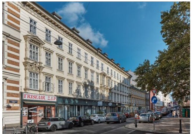
Schönbrunner Straße 20-24 | Fassade
