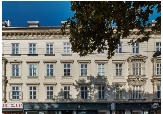
Schönbrunner Straße 20-24 | Fassade
