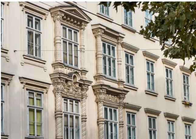
Schönbrunner Straße 20-24 | Fassade
