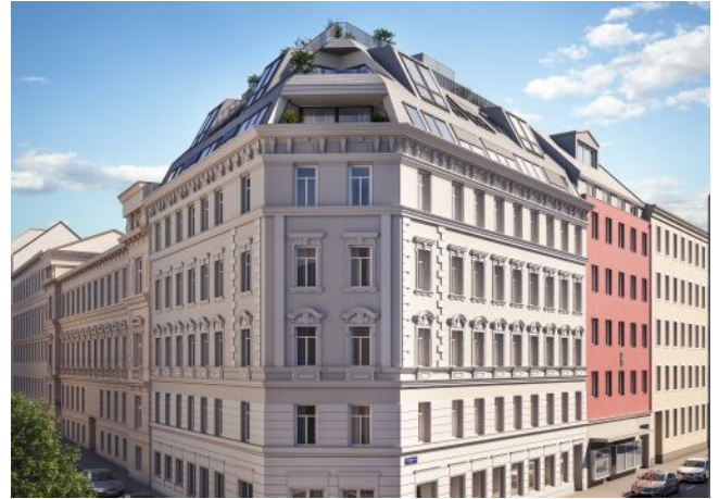
Vivienne | Fassade Tag
