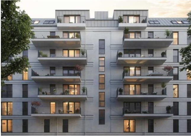
Wiedner Hauptstrasse 140 | Fassade Straße
