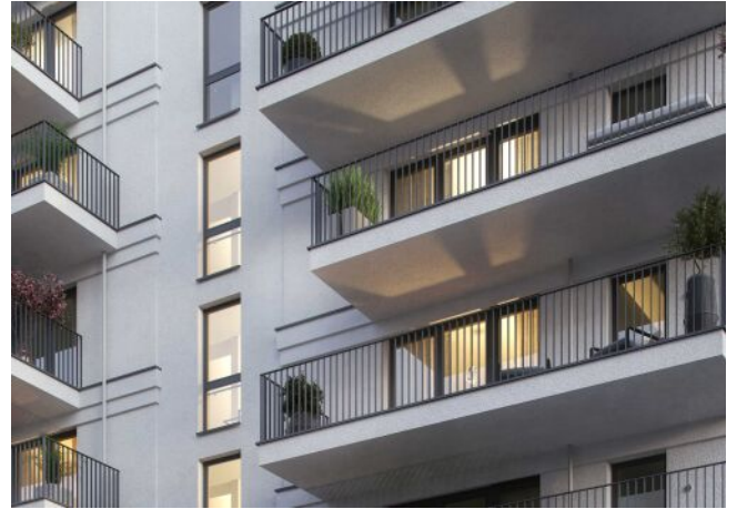
Wiedner Hauptstrasse 140 | Fassade Straße
