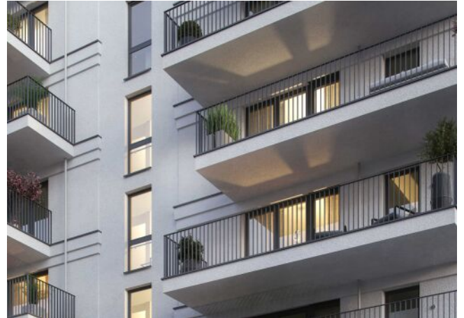
Wiedner Hauptstrasse 140 | Fassade Straße
