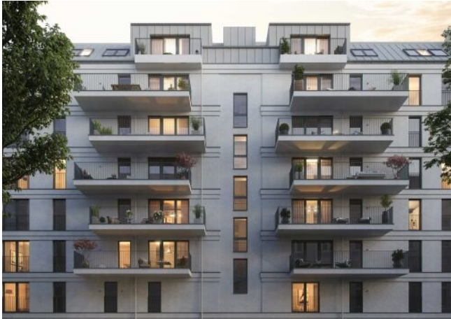
Wiedner Hauptstrasse 140 | Fassade Straße
