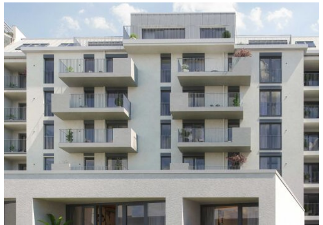
Wiedner Hauptstrasse 140 | Fassade Hof
