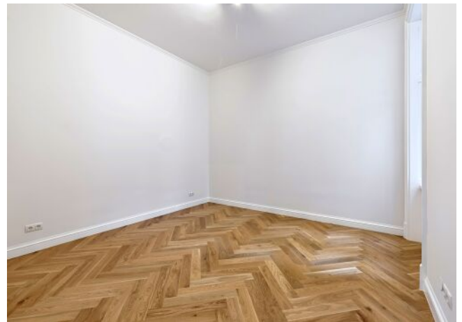
Beispielfoto nach Sanierung
