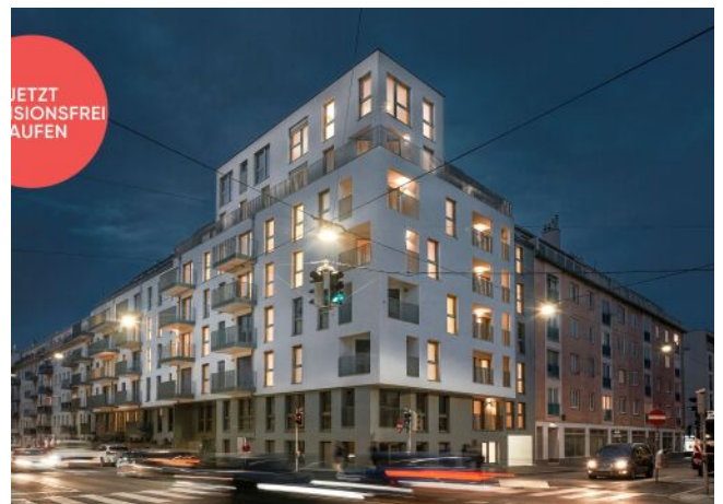
Arndtstraße 50 | Fassade Nacht
