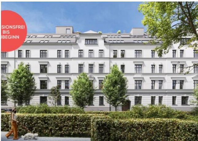
Rosegggasse | Fassade Frontal
