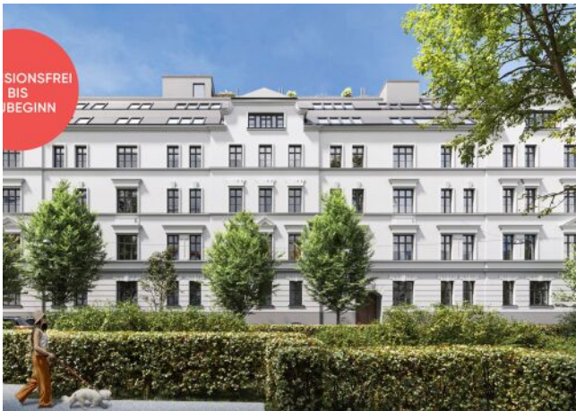
Rosegggasse | Fassade Frontal
