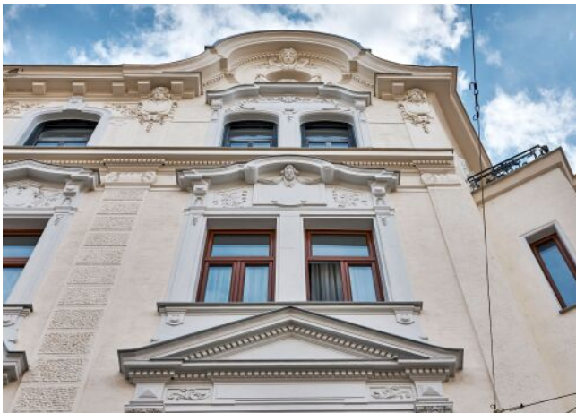
Bergsteiggasse 26A | Fassade
