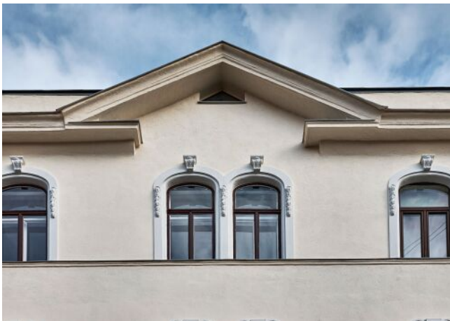
Bergsteiggasse 26A | Fassade
