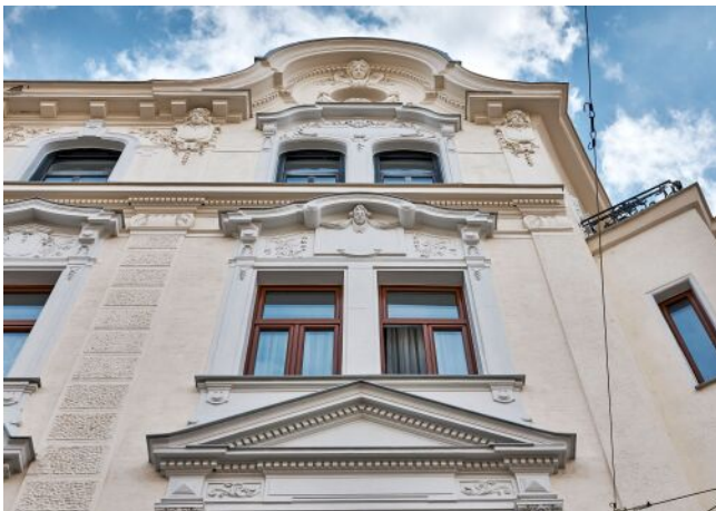
Bergsteiggasse 26A | Fassade
