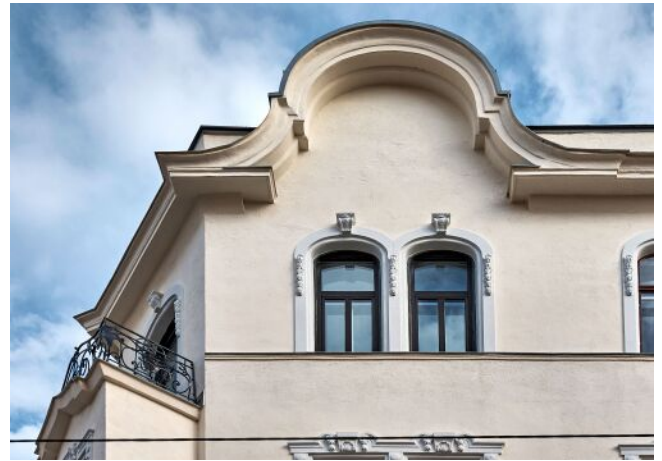
Bergsteiggasse 26A | Fassade
