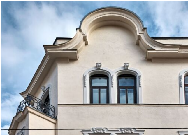
Bergsteiggasse 26A | Fassade
