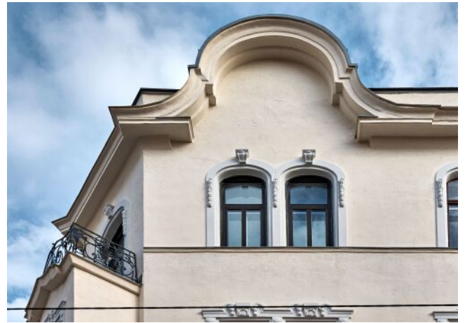
Bergsteiggasse 26A | Fassade
