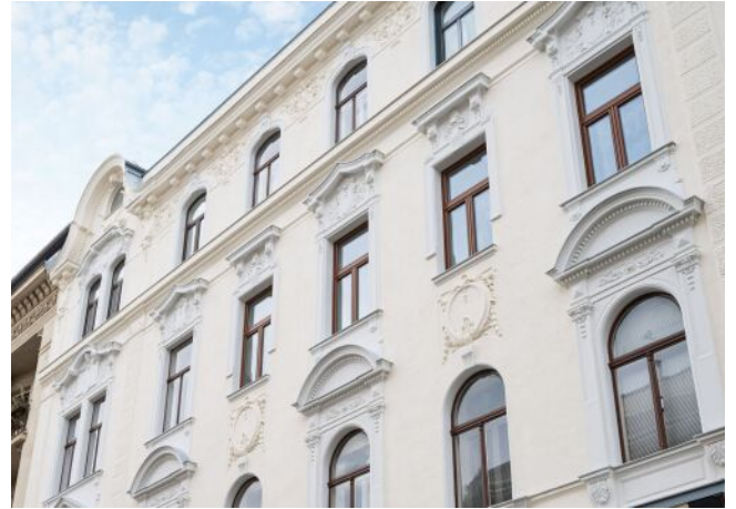
Bergsteiggasse 26A | Fassade
