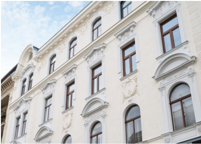
Bergsteiggasse 26A | Fassade
