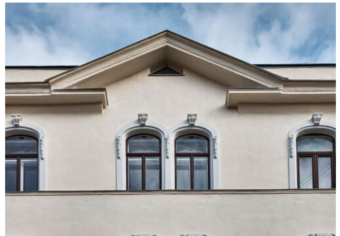
Bergsteiggasse 26A | Fassade
