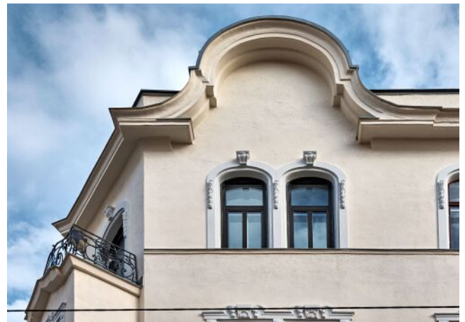
Bergsteiggasse 26A | Fassade
