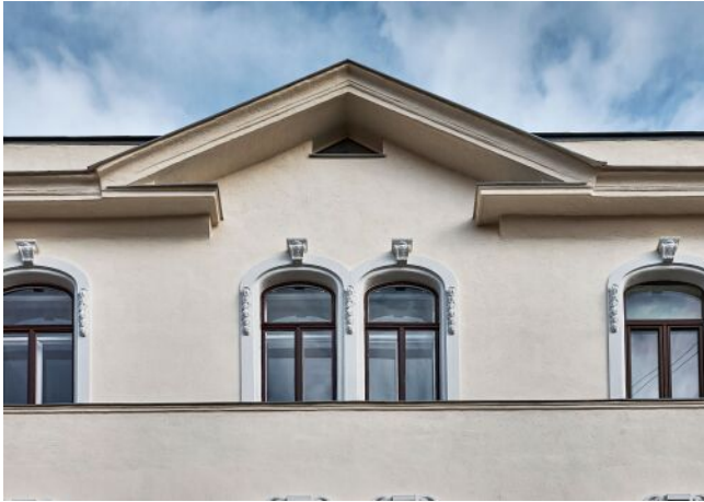
Bergsteiggasse 26A | Fassade
