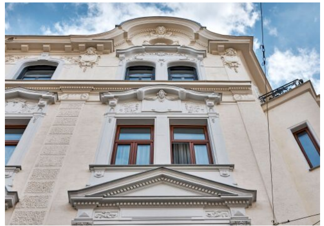
Bergsteiggasse 26A | Fassade
