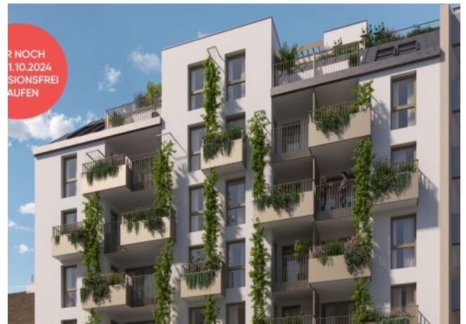
Ottakringer Straße 26 | Fassade
