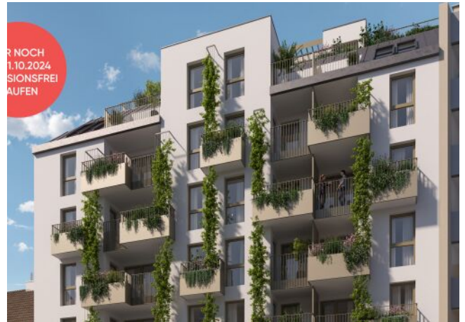
Ottakringer Straße 26 | Fassade
