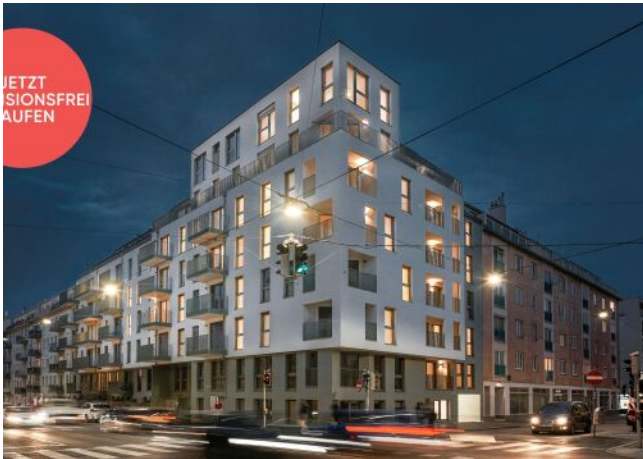
Arndtstraße 50 | Fassade Nacht
