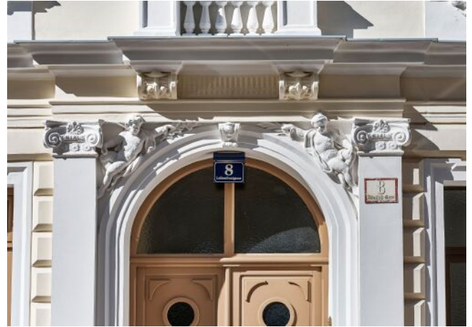
Leibenfrostgasse 8 | Fassade Detail
