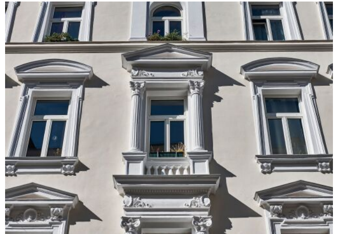
Leibenfrostgasse 8 | Fassade Detail
