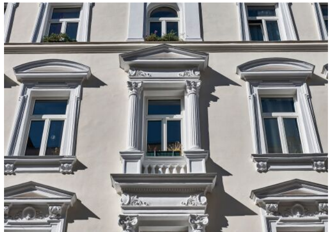
Leibenfrostgasse 8 | Fassade Detail
