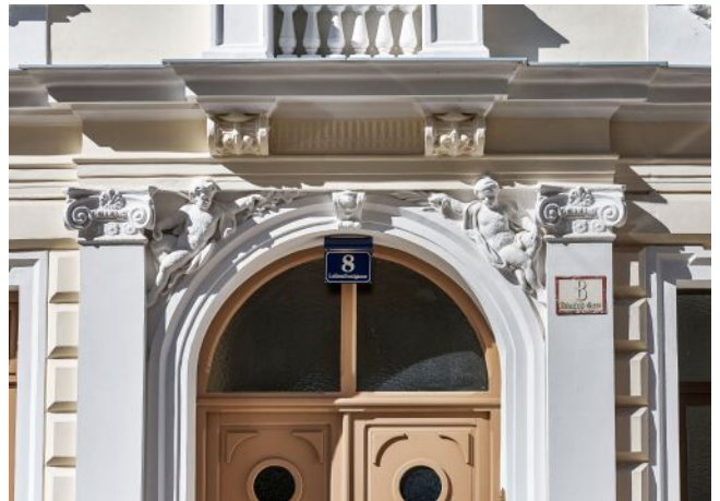
Leibenfrostgasse 8 | Fassade Detail
