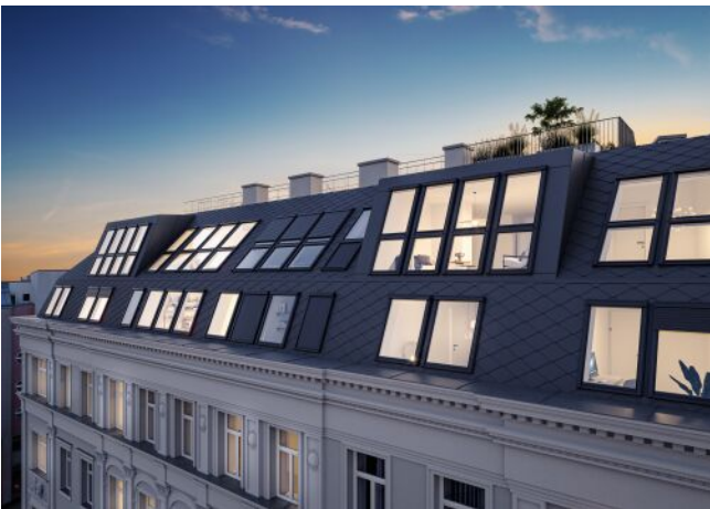
The Legacy | Dachgeschoss
