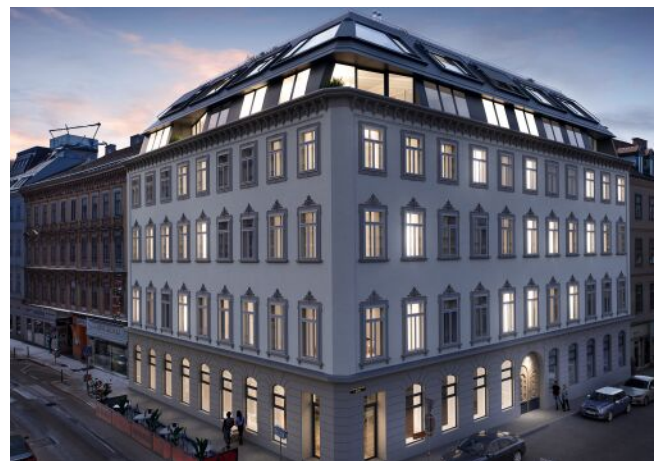
Essenz No. 1 | Fassade Abend
