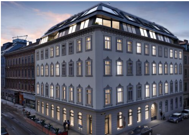
Essenz No. 1 | Fassade Abend
