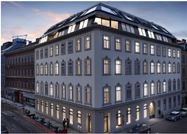
Essenz No. 1 | Fassade Abend
