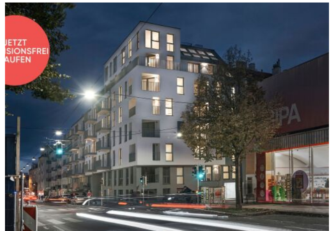
Arndtstraße 50 | Fassade Nacht
