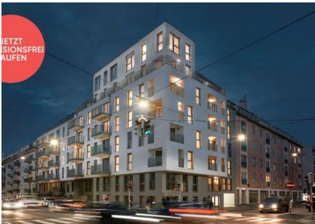
Arndtstraße 50 | Fassade Nacht
