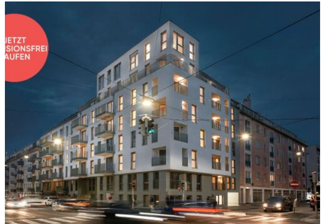
Arndtstraße 50 | Fassade Nacht
